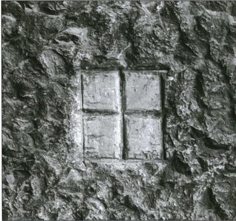
Wijdingskruis in de arduinstijl van de ingangspoort van de kerk van Lot.
