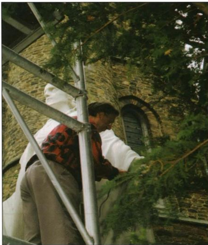
Maurits Nevens voert restauratiewerk uit aan het H. Hartbeeld.
